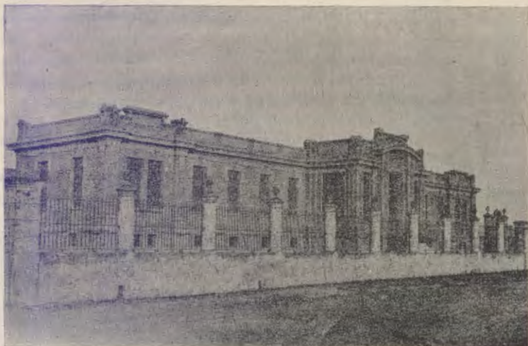
Vista lateral del frente
